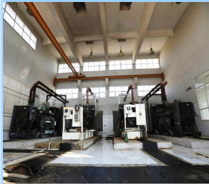
تركيب المولدات الكهربائيتين رقم (1) - (2) نوع باركفاز قدرة 640KW
